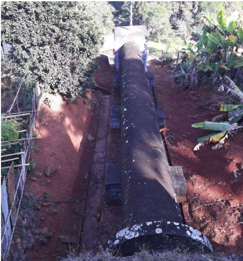
Foto 14. Estrutura da câmara de carga e início do conduto forçado
