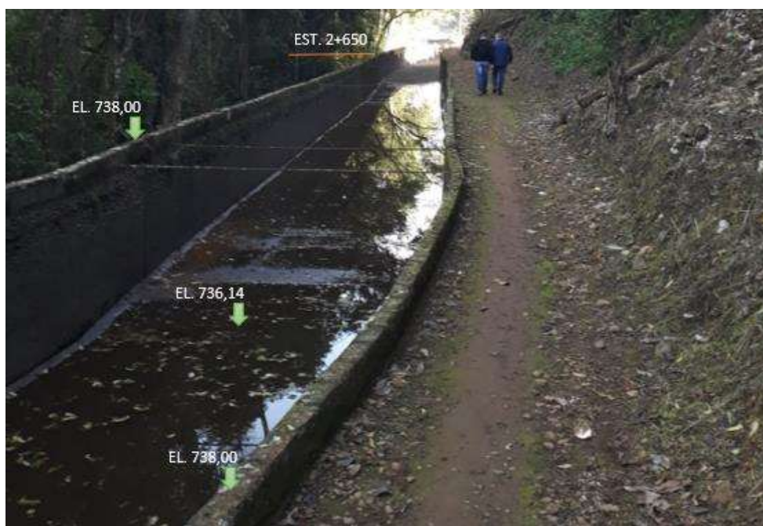
Foto 11. Canal de adução: trecho escavado em solo e rocha
