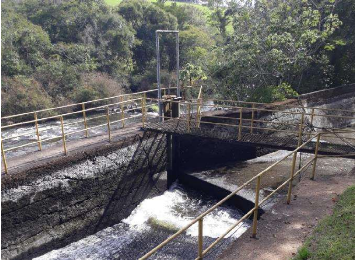
Foto 7. Desarenador do canal de adução: vista da estrutura e da válvula da comporta
