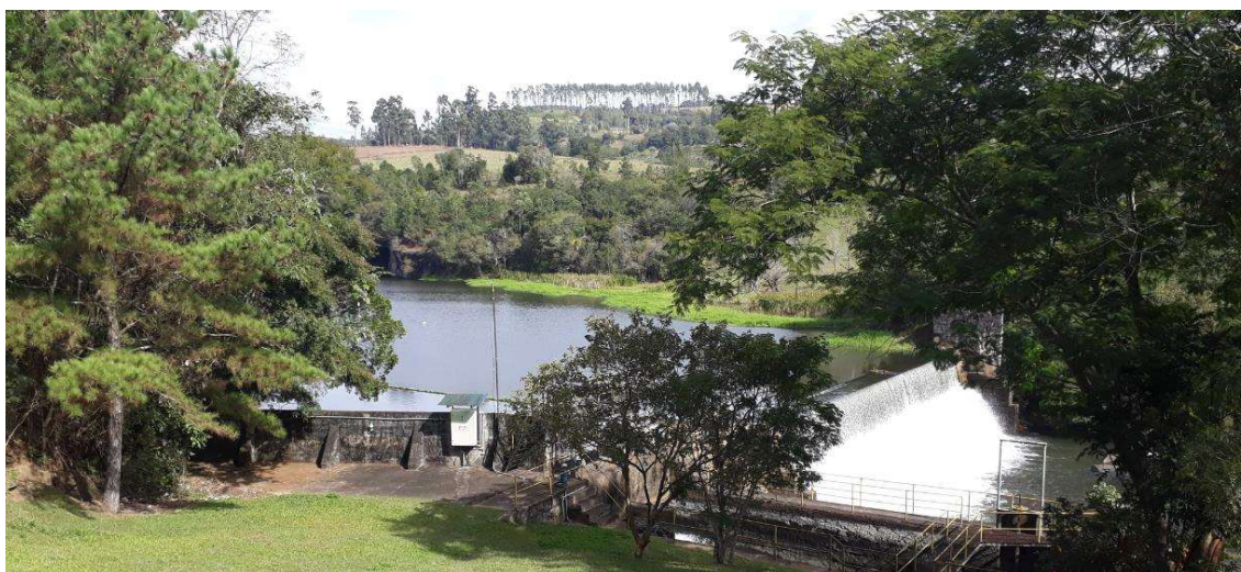
Foto 20. Vista geral do reservatório
