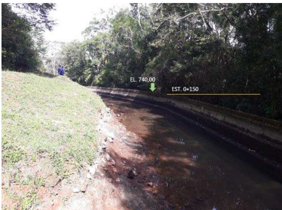
Foto 10. Canal de adução: trecho parcialmente revestido em concreto
