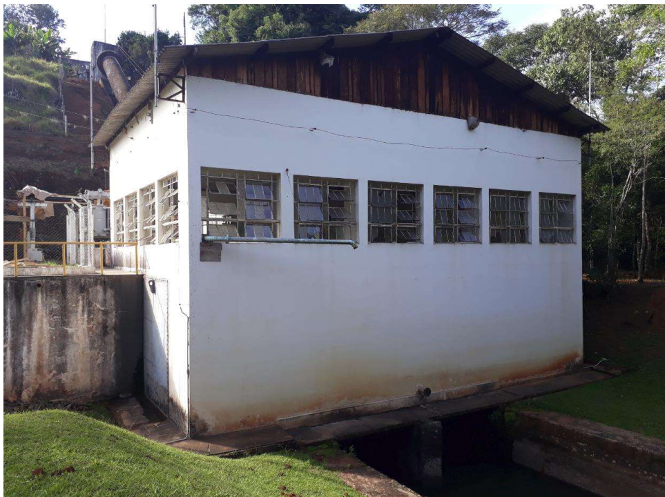
Foto 17. Piso superior da casa de força
