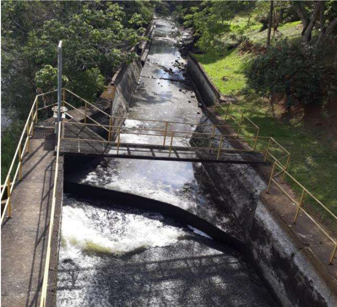
Foto 6. Estrutura da tomada d'água e início do canal de adução
