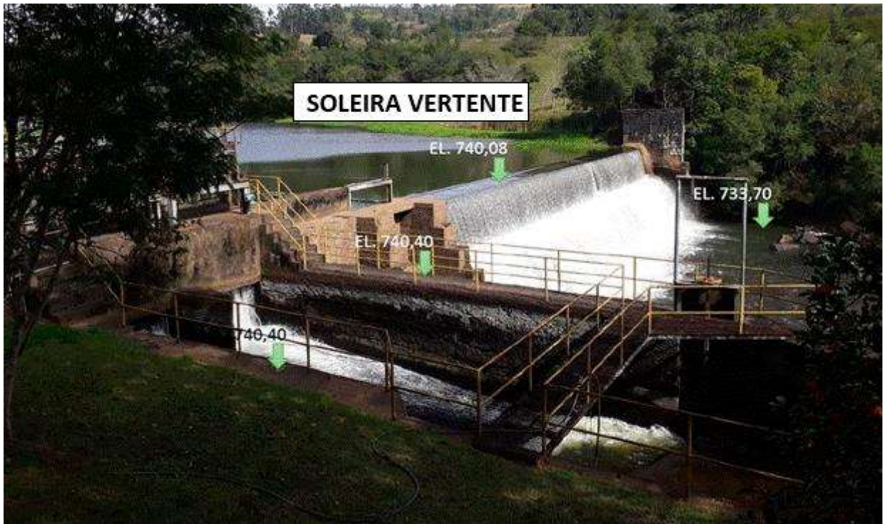
Foto 3. Barragem (ombreira direita), vertedouro e tomada d'água.
