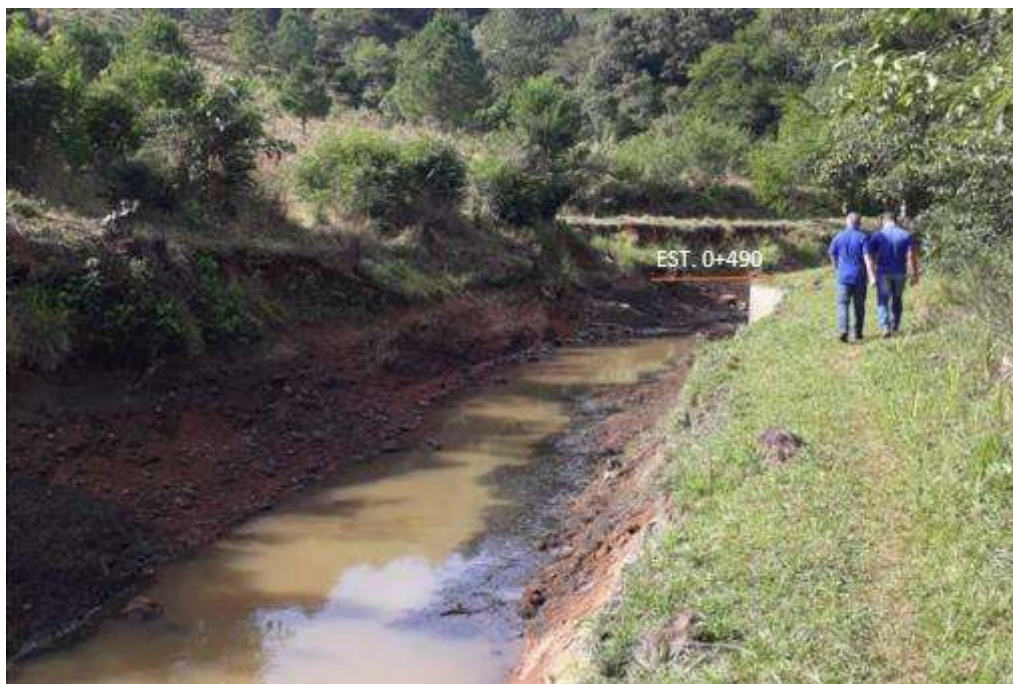
Foto 11. Canal de adução: trecho escavado em solo e rocha
