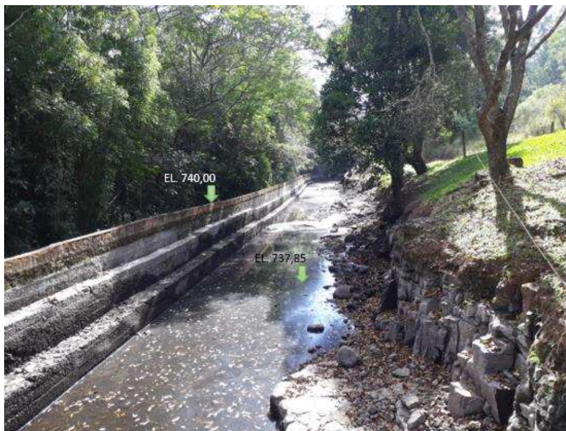
Foto 9. Canal de adução: trecho inicial revestido em concreto, seguido de trecho escavado em solo e rocha
