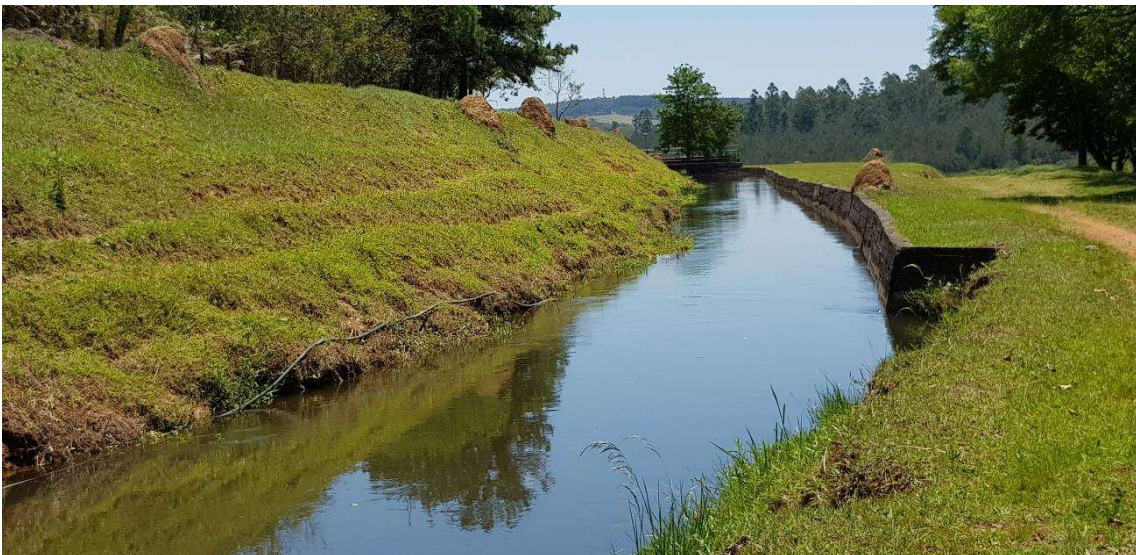
Foto 11. Canal de adução: trecho final até a câmara de carga parcialmente revestido em concreto
