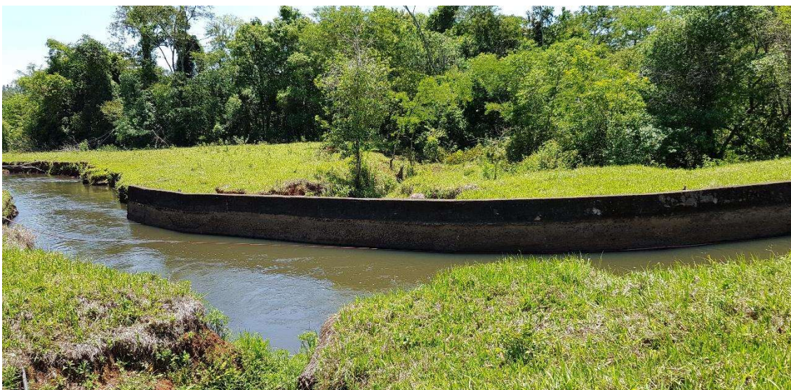
Foto 9. Canal de adução: trecho parcialmente revestido em concreto
