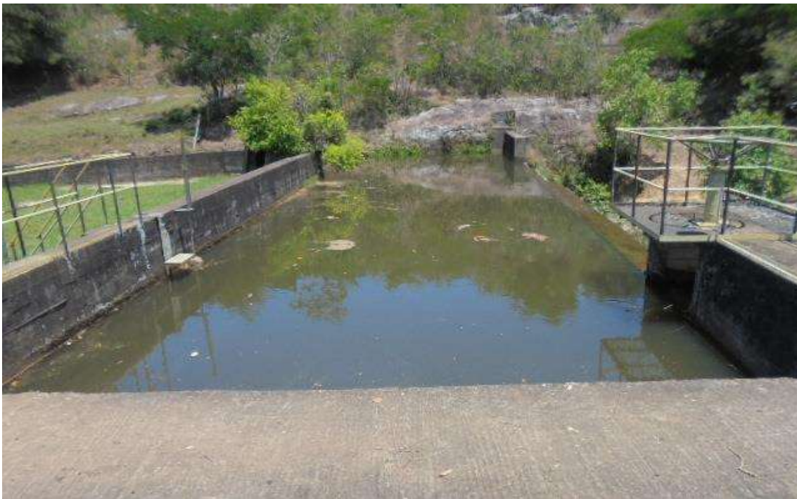
Foto 12. Câmara de carga e vertedouro lateral
