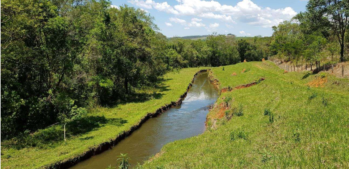
Foto 10. Canal de adução: trecho escavado em solo e rocha
