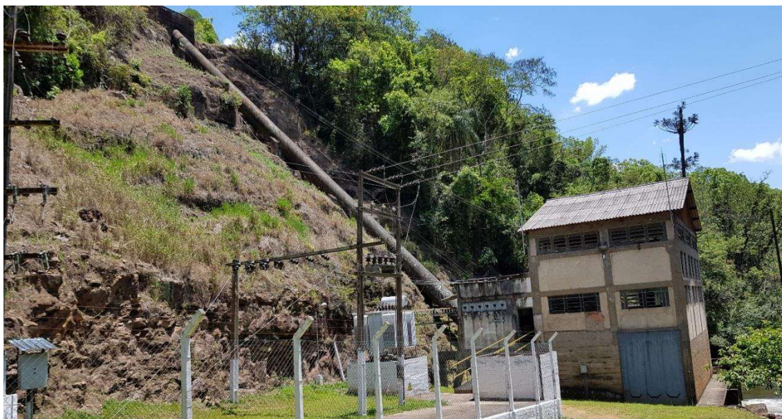
Foto 14. Subestação, conduto forçado e casa de força
