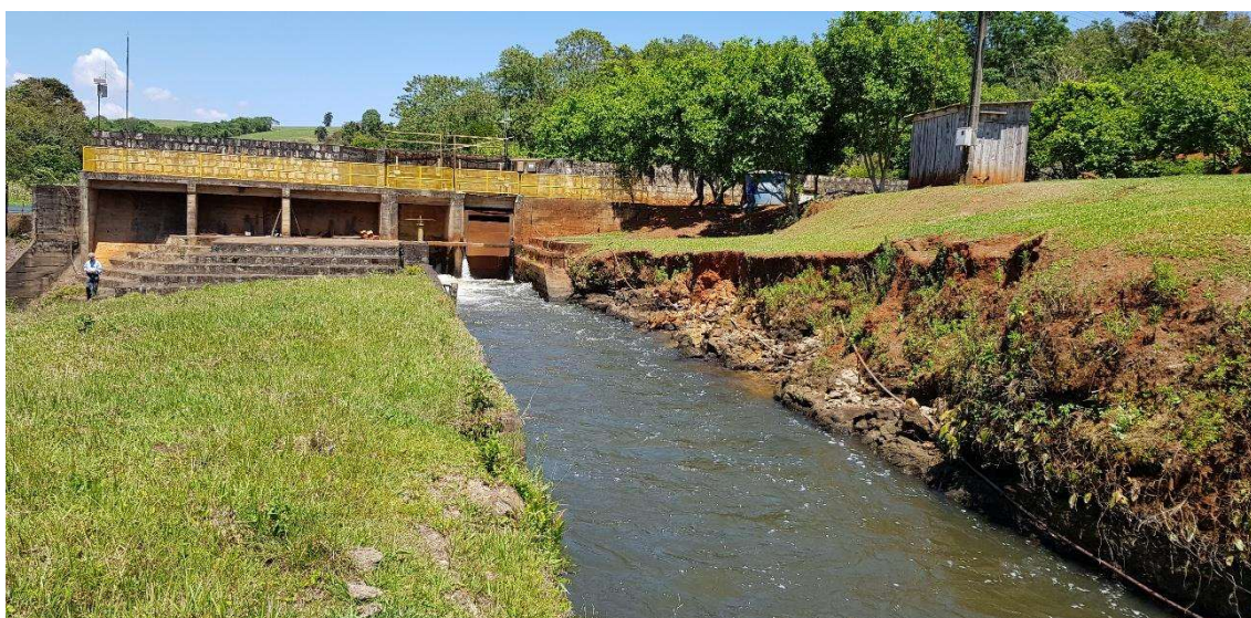
Foto 5. Estrutura da tomada d'água e início do canal de adução
