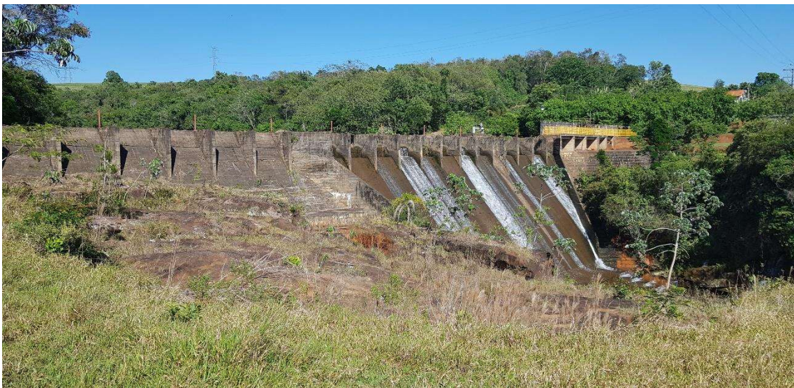
Foto 2. Barragem (ombreira direita), vertedouro e tomada d'água.
