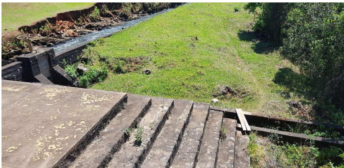
Foto 6. Desarenador do canal de adução: vista da estrutura e da válvula da comporta
