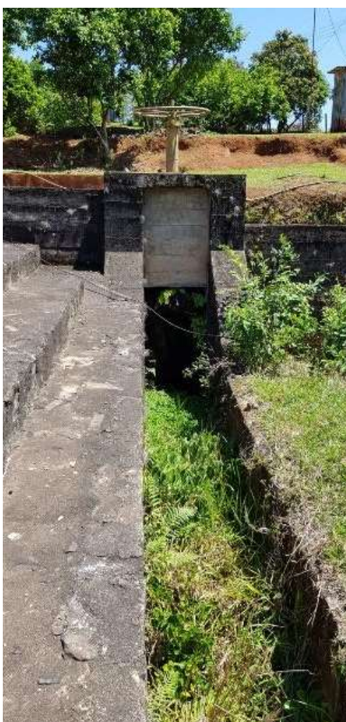
Foto 7. Desarenador do canal de adução: válvula da comporta e canal de escoamento
