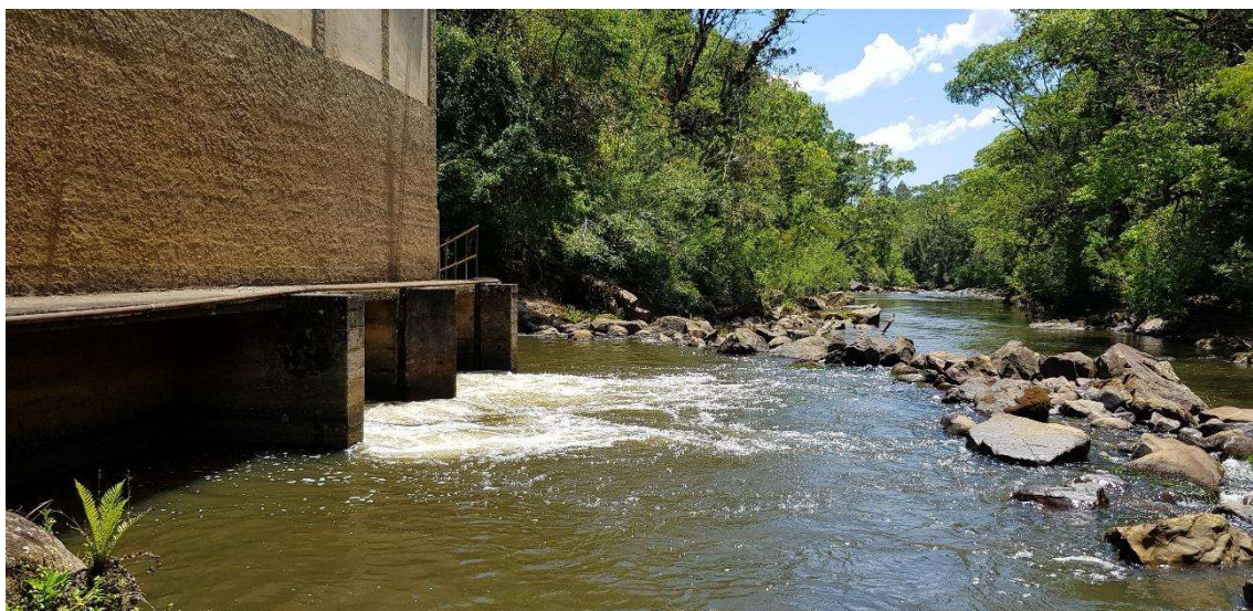
Foto 18. Canal de fuga
