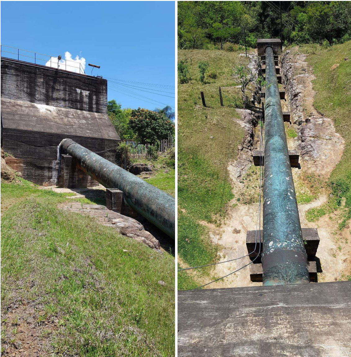
Foto 13. Estrutura da câmara de carga e início do conduto forçado
