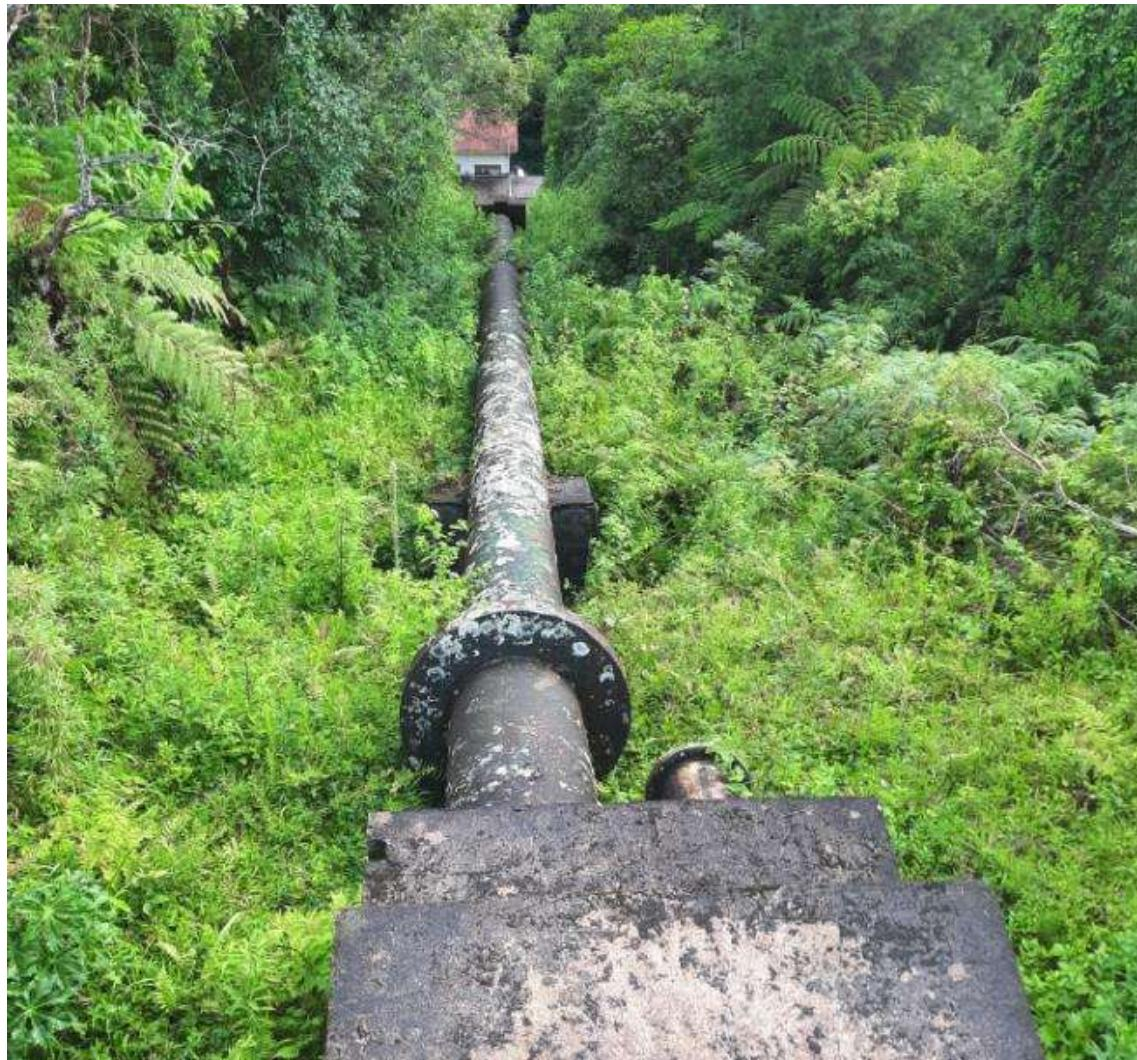
**Foto 9. Estrutura da câmara de carga e início do conduto forçado**
