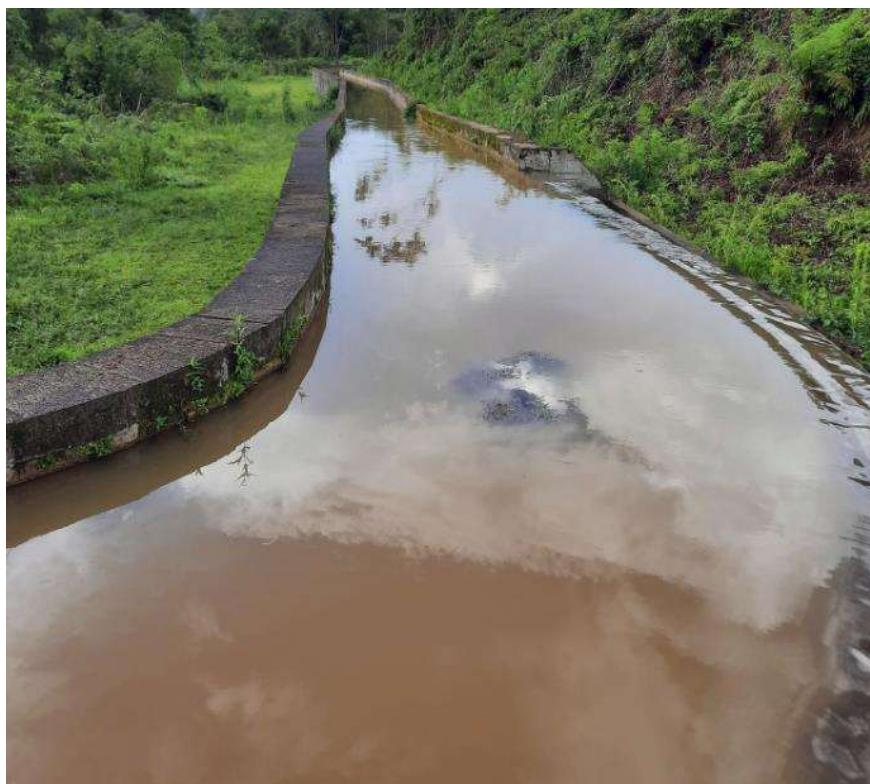
Foto 7. Canal de adução: trecho final em concreto
