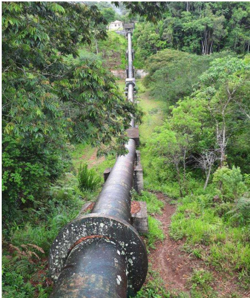
Foto 3. Sifão em tubulação de ferro fundido
