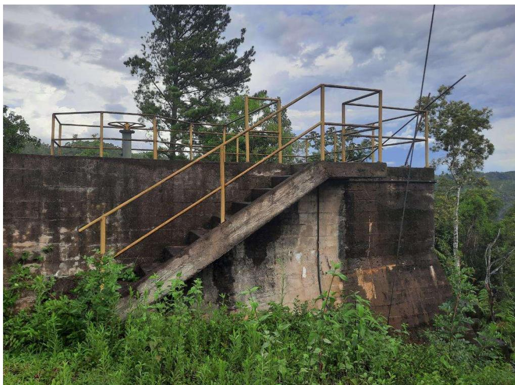
Foto 8. Câmara de carga e vertedouro lateral
